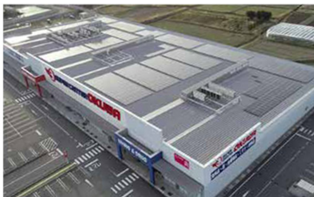
スーパーセンターオークワ河南店屋上の太陽光パネル
